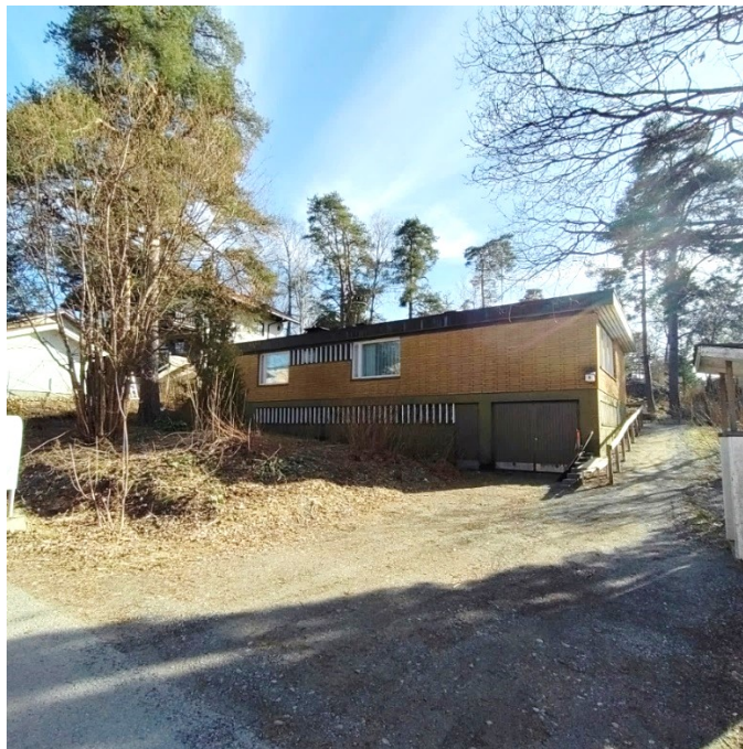
Kuva 2. Tontin asuinrakennuksen pohjoisjulkisivu Lehvänkadulta kuvattuna. Purkukuntoiseksi todetun rakennuksen varsinaiset asuintilat sijaitsevat kellaritilojen ja autotallin päällä. Rakennuksen pääsisäänkäynti ja oleskelupiha sijaitsevat rakennuksen eteläpuolella. Kuva: Anna-Kaisa Anttila 2025.
